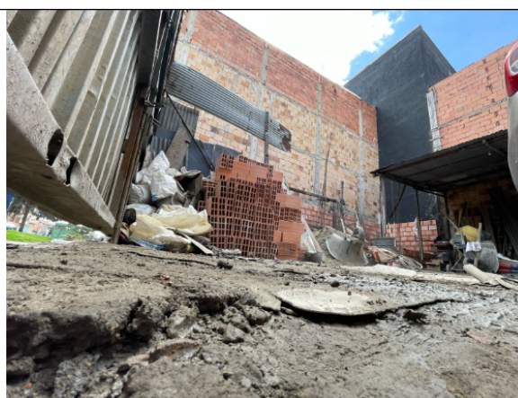
Fotografía 8. Actividades constructivas dentro del predio con CHIP AAA0271TWLF
