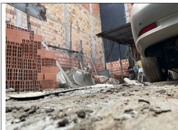
Fotografía 7. Actividades constructivas dentro del predio con CHIP AAA0271TWLF
